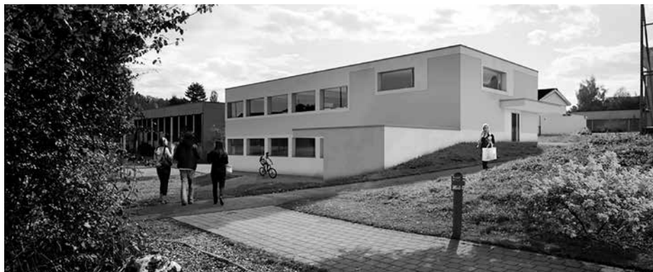
Aussenansicht der neuen Schwinger- und Ringerhalle: Standort ist im Sportzentrum Schlossfeld neben der 3-fach-Turnhalle Hallenbad.
